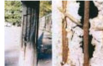
Korozija čelične armature betonskog rasvjetnog stupu
