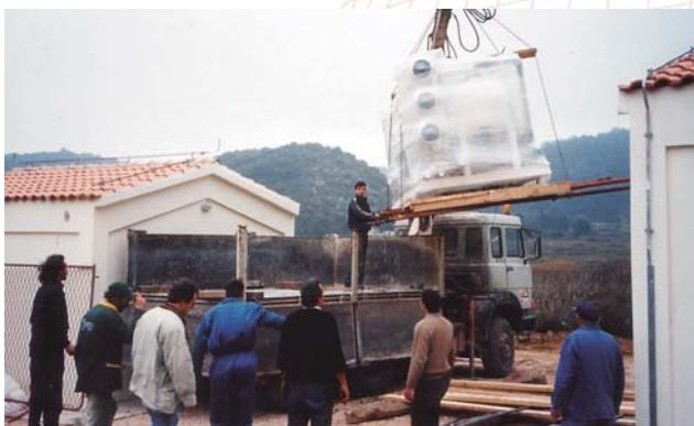
Dopremanje jedinice za reverzno osmotsku desalinaciju bočate vode u Prgovu polju na Lastovu, ljetо 1997.
