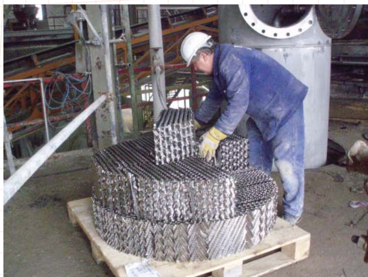
Priprema punila kolone za ugradnju.
